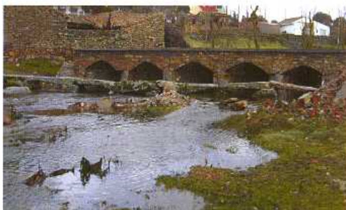
Fariza. Puente sobre la rivera que cruza el pueblo.
